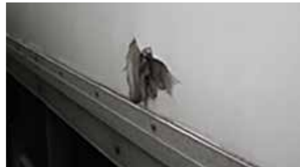
Holzseitenverkleidungen: Beschädigte Holzstütze \geq 20\text{ cm}
