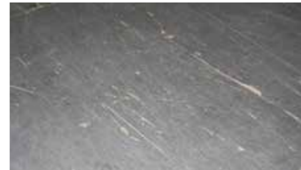
Bodenbelag: Leichte Verformung, oberflächlicher Verschleiß
