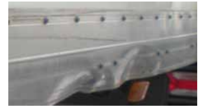
Unterboden-Seitenprofile: Verformungen, die nicht auf wirtschaftliche Weise repariert werden können, Durchdringungen, fehlende Profilabschnitte
