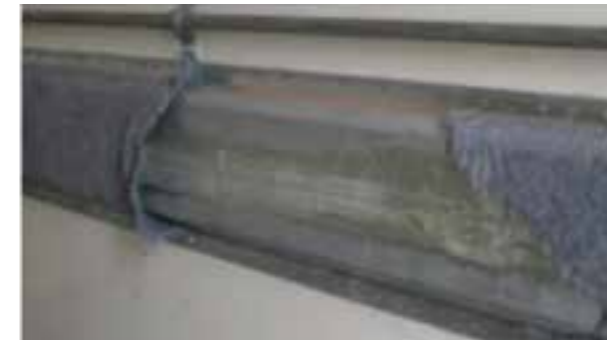
Polsterung und Stangen: Teppich gerissen oder abgelöst
