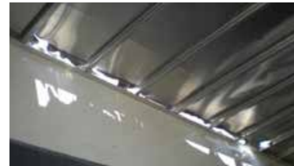
↻ Dachfläche: Rahmen beschädigt, kann nicht auf wirtschaftliche Weise repariert werden
