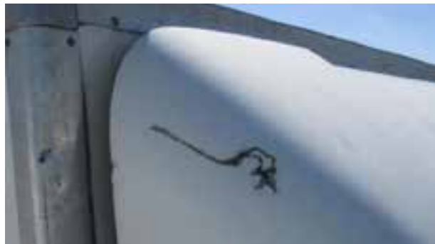
Kabinenabdeckung und Abweiser: Kann auf wirtschaftliche Weise repariert werden
