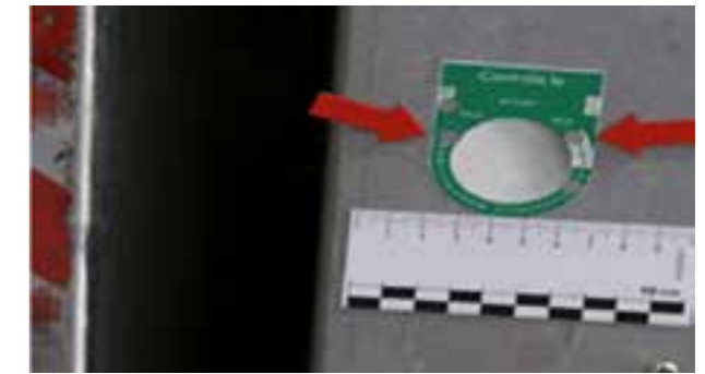
🔧 Ladebordwand: Prüfintervall überschritten
