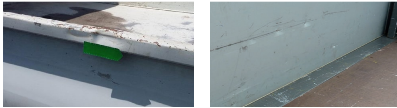
Leichte Kratzer, Schienenverformungen mit Reparaturzeit \leq 1 h
