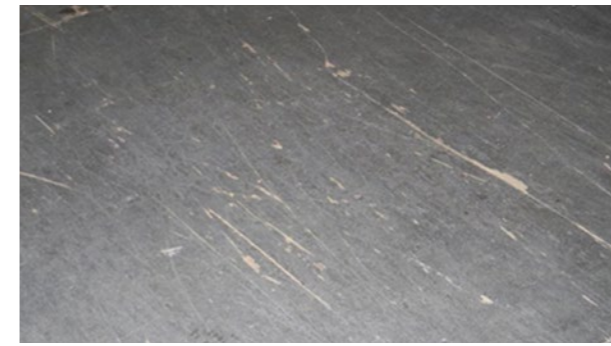
Bodenbelag: Leichte Verformung, oberflächlicher Verschleiß
