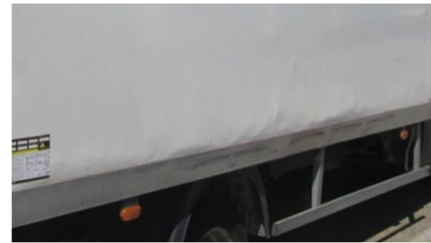
GFK-Seitenverkleidungen: Verformung am Unterteil, Länge > 1\text{ m} Bitte beachten: Der Austausch der vorderen Tafel des Unterbodens erfordert den Ausbau des Unterbodens.
