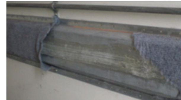
Polsterung und Stangen: Teppich gerissen oder abgelöst
