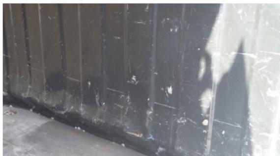
Innere Verformungen: Leichte Verformung ohne Durchdringungen oder Schnitte, Reparaturzeit ≤ 3 h
