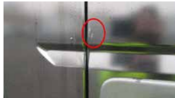
Éclat sur tranche de portes
