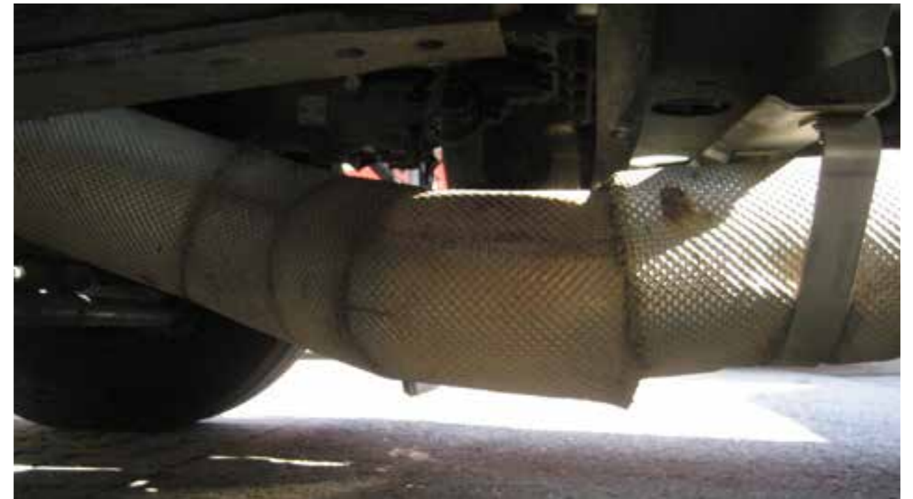
Les éléments suivants ne sont pas acceptés : tuyaux cassés, isolation thermique détériorée, rayures profondes dans le matériel, bosses qui réduisent le diamètre du tuyau.
