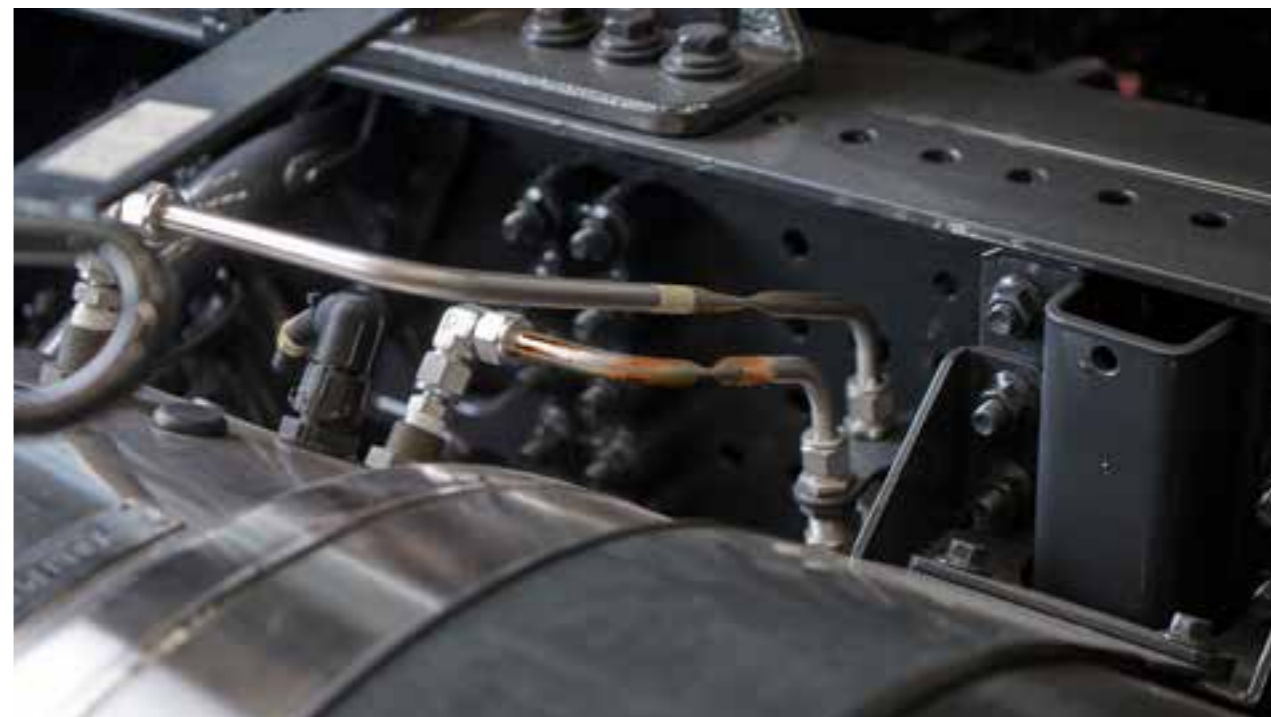
Rouille, bosses, ruptures et/ou rayures → facturer le remplacement des conduites rigides.
