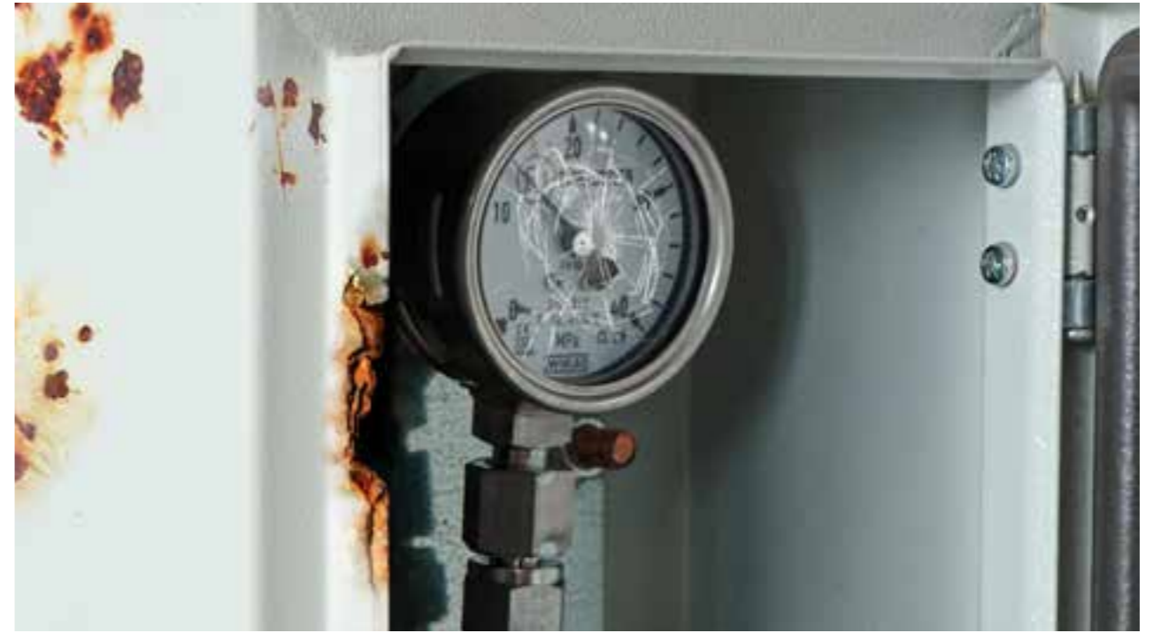
Clé du boîtier de protection absente, orifice de GNC ou manomètre endommagé → facturer le remplacement du boîtier complet.
