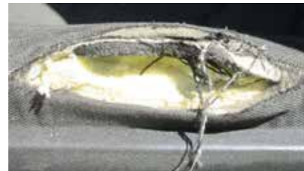
Manque de mousse ou structure cassée
