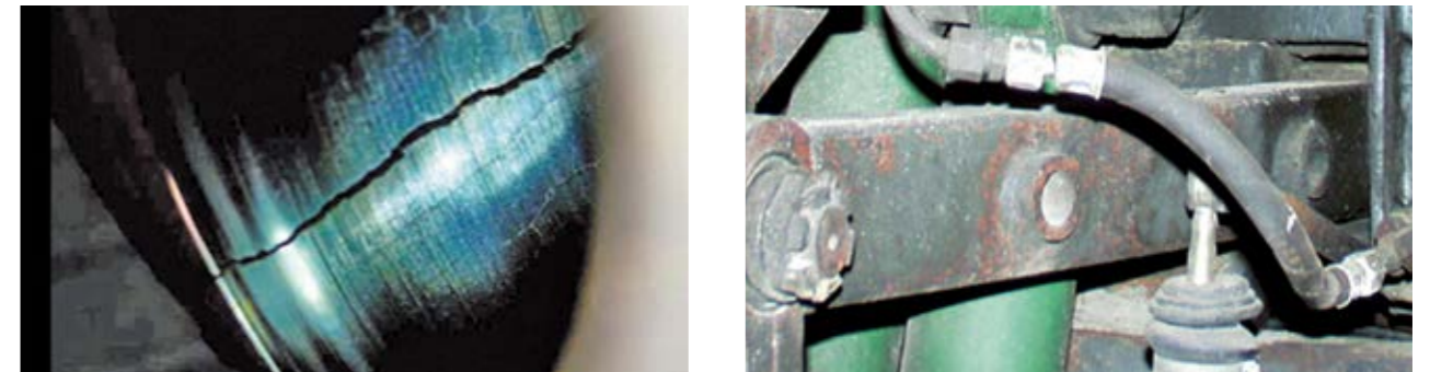
Non conforme au code de la route et non valide au contrôle technique
